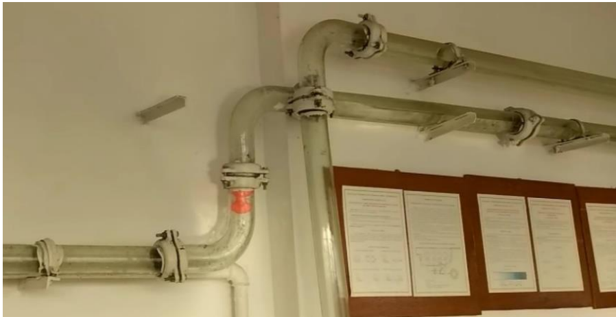
Рисунок 9 – Застрягання гантелеподібного трикулевого очисного поршня зі силіконового компаунда в місці резинового ущільнення з'єднання скляних труб і перетікання через нього повітря
