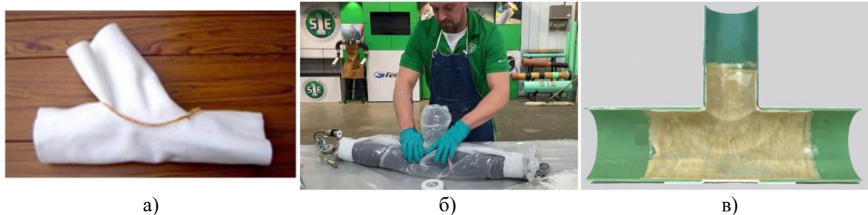
Рисунок 12 – Ремонт трійників CIPP методом
