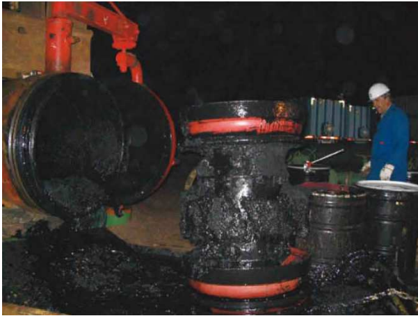
Рисунок 3 – Видалений з магістрального нафтопроводу чорний порошок
