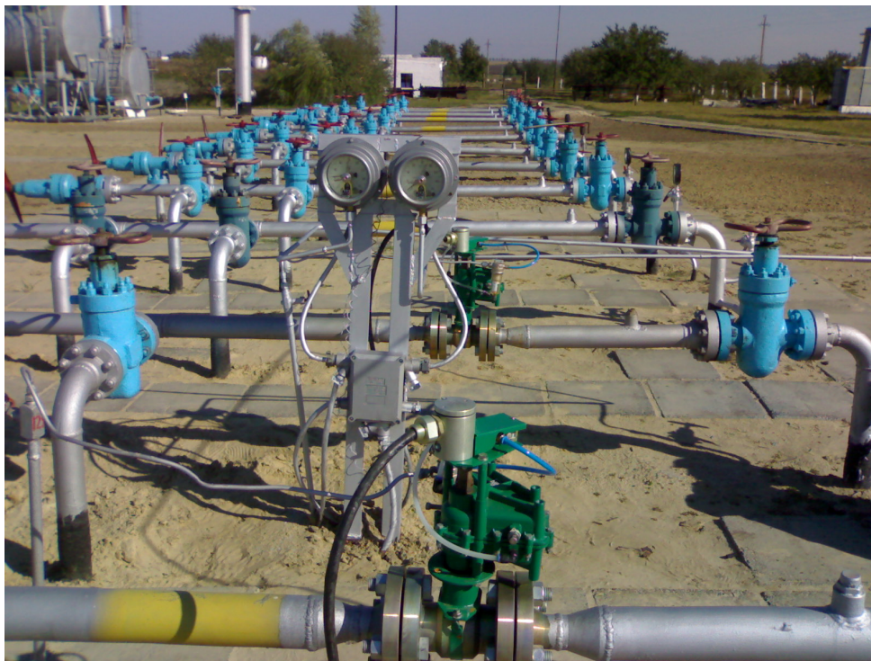
Рисунок 2 – Зразок автоматичних комплексів керування свердловинами на УКПГ № 3 Шебелинського ГКР
