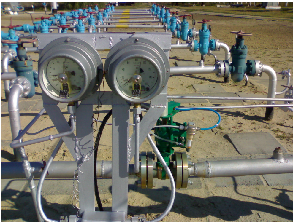
Рисунок 3 – Зразок автоматичних комплексів керування свердловинами на УКПГ № 3 Шебелинського ГКР
