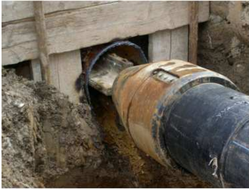
Рисунок 6 – Розширювач для руйнування дефектного металевго трубопроводу
