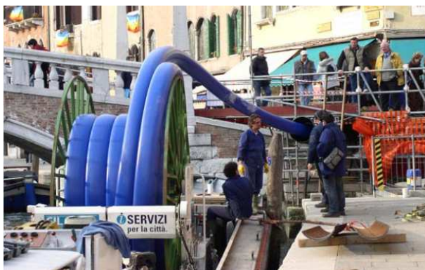
Рисунок 5 – Ремонт трубопроводу методом “труба в трубі” в місті Венеція
