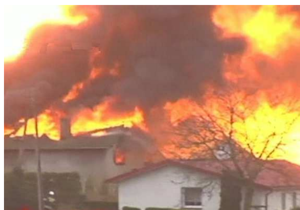
Рисунок 2 – Наслідки аварії мережі газопостачання
