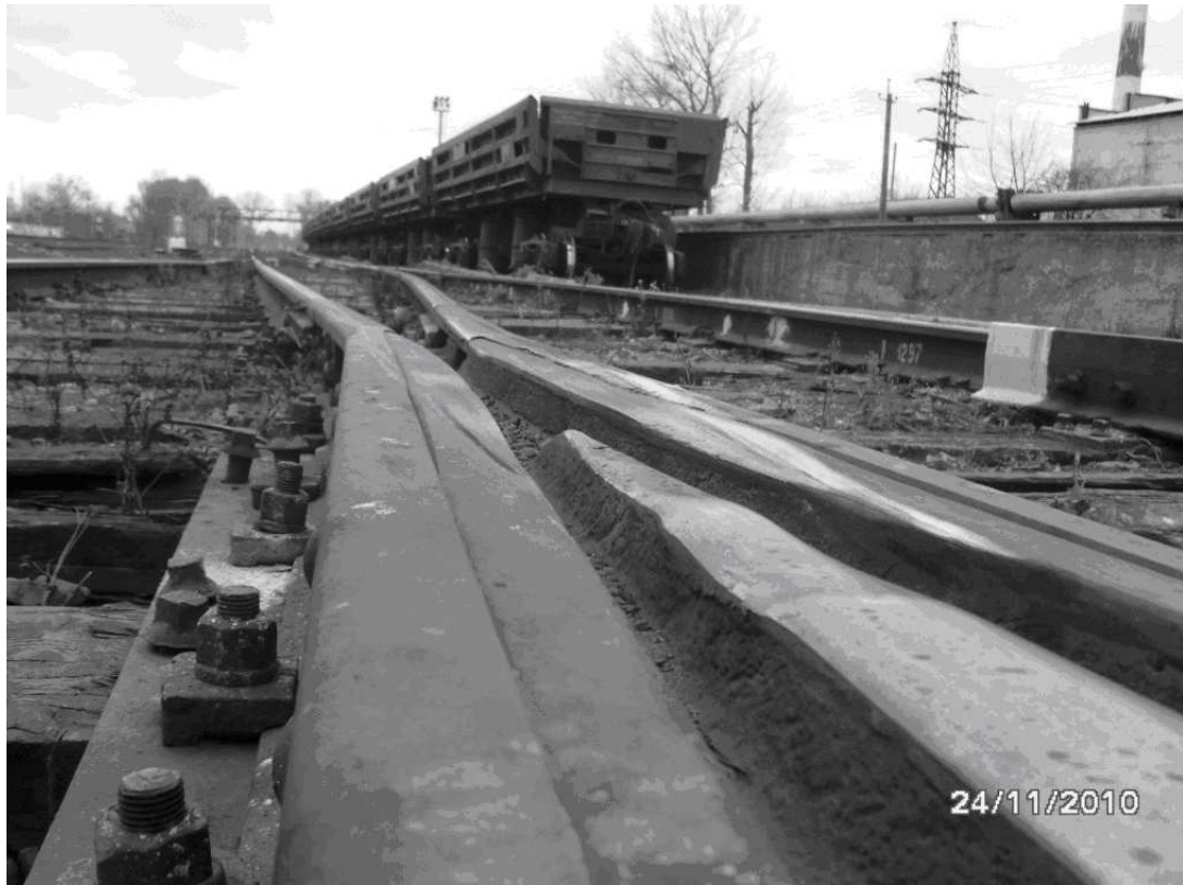
Рисунок 1 – Спрацьовані частини елементів хрестовини
