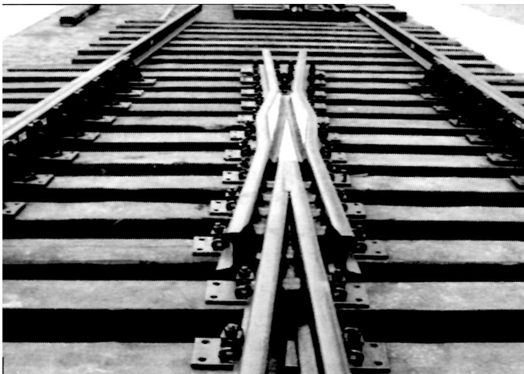
Рисунок 2 – Загальний вигляд хрестовини залізничних стрілкових переводів
