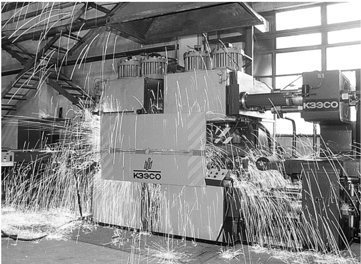
Рисунок 5 – Процес зварювання хрестовини стрілкового переводу
