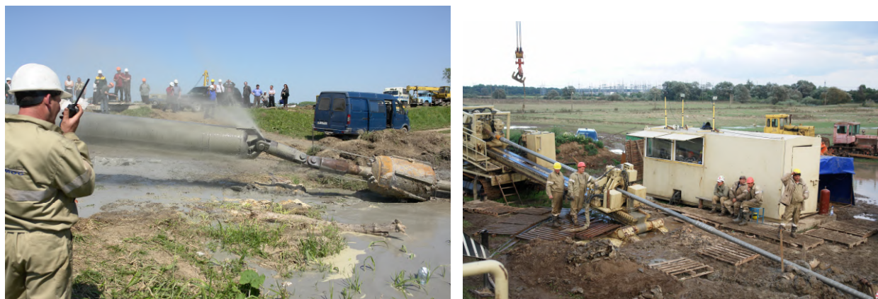
Рисунок 1 – Робочий майданчик для проведення ГНБ
