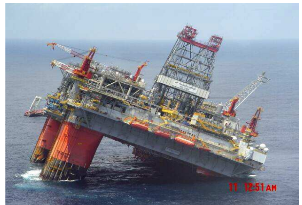
Рисунок 4 – Руйнування бурової установки «NDC Al Mariyah» [8]
