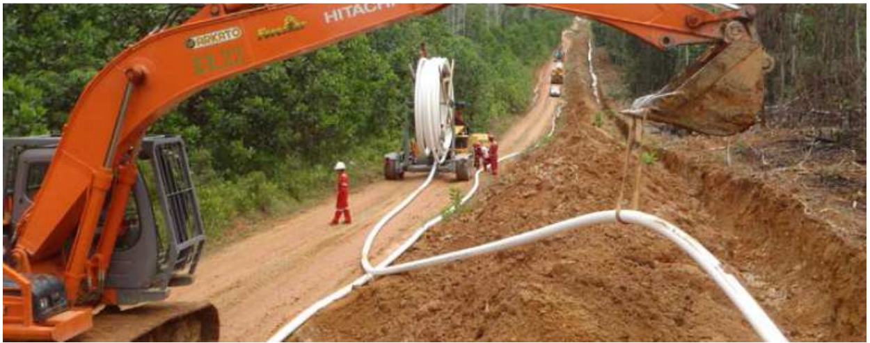
Рисунок 9 – Укладання гнучкого композитного трубопроводу одноковшовим екскаватором
