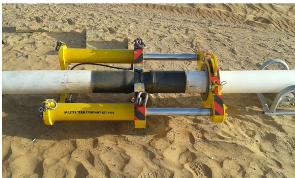
Рисунок 8 – Встановлення фітинга
