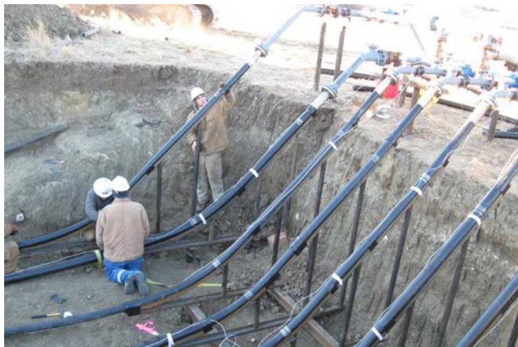
Рисунок 10 – Розміщення гнучких композитних труб на стоякових жолобах
