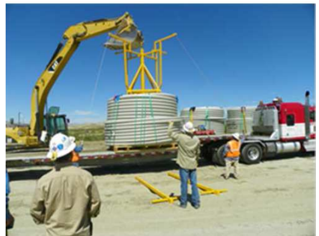
Рисунок 4 – Поміщення підйомного пристрою в середину бухти
