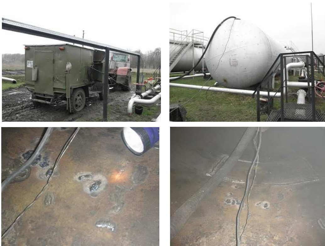
Рисунок 4 – Ремонт і контроль виконання зварювальних робіт
