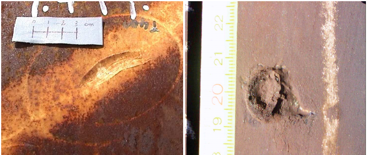
Рисунок 3 – Приклади механічних пошкоджень основного металу технологічної обв'язки НПС магістральних нафтопроводів
