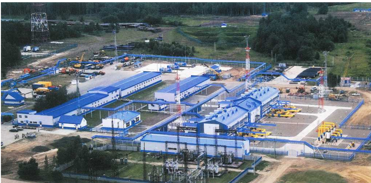
Рисунок 1 – Компресорна станція (КС) Парабель
