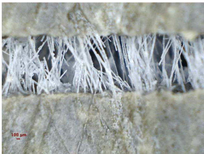
Рисунок 2 — Характер розташування ППФ в тріщині цементного каменю (x20) М 20:1
