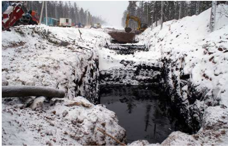
Рисунок 6 – Розгерметизація нафтопроводу Східний Сибір – Тихий океан в Приамурському краї, Росія
