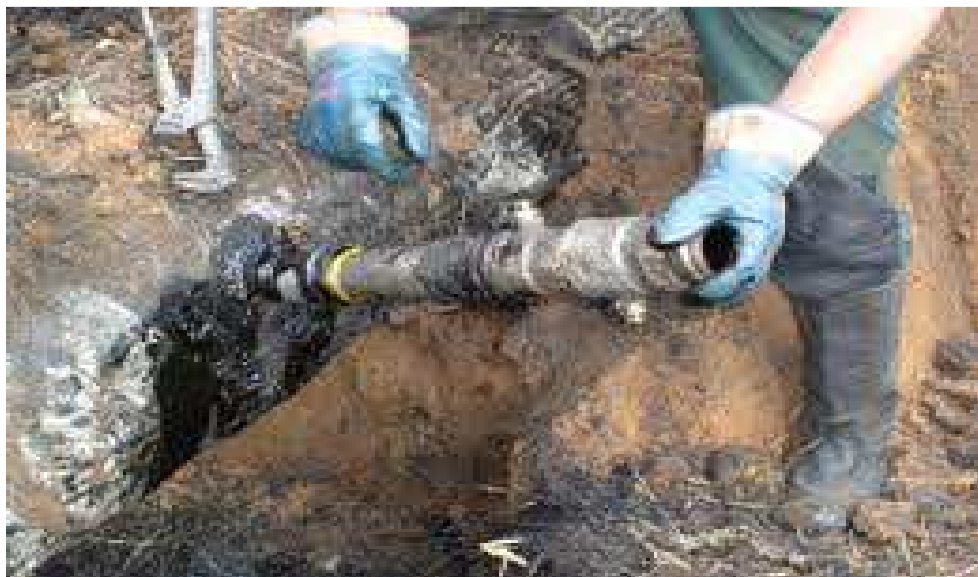
Рисунок 8 – Несанкціоноване врізання в нафтопровід «Дружба» в Закарпатській області
